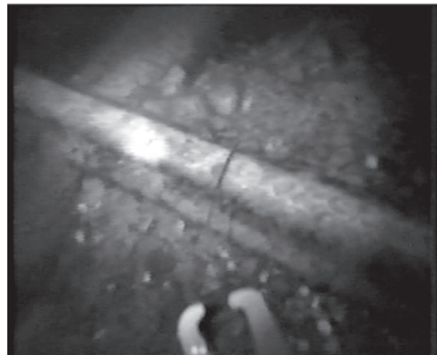
Fot. 12. Prawidłowo podparte torowisko slipu
