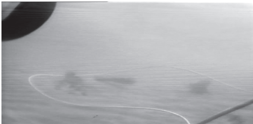
Fot. 7. Ułożenie kabloliny przy dnie akwenu
