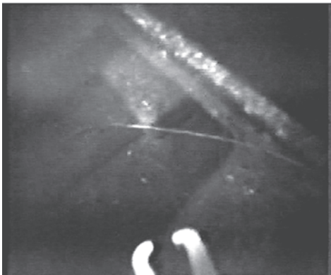
Fot. 11. Podmyty fragment torowiska slipu
